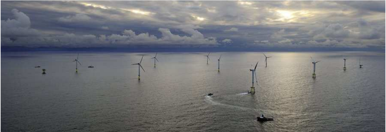
Fig. 35 – Wind farm Alpha Ventus – Borkum West nel Mare del Nord (Germania).
