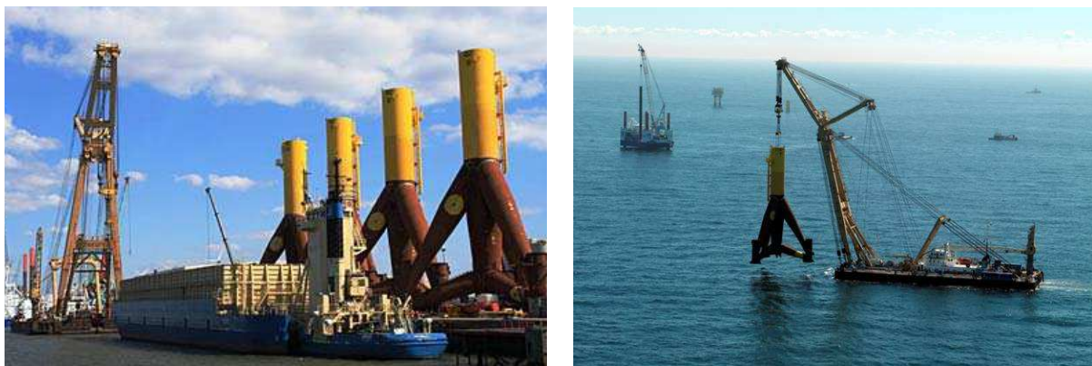
Fig. 23 – Fondazioni tripode installate nel parco eolico Alpha Ventus (Germania).
