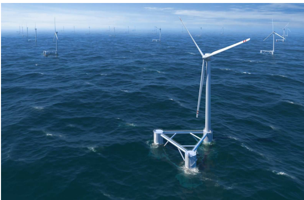
Fig. 26 – Fondazioni floating (sinistra) e aerogeneratore installato presso Karmoy (Norvegia) (destra).
