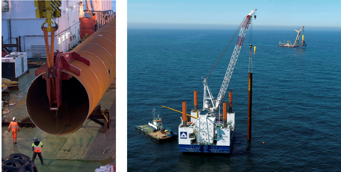
Fig. 19 – Fondazione a monopalo installata nel Mare del Nord (Prinses Amalia windfarm).
