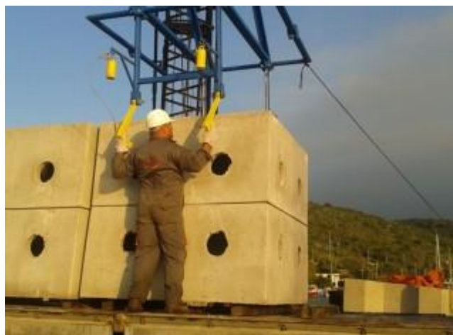
Figura 28: Corpi morti Sea Friendly installati in provincia di Grosseto
