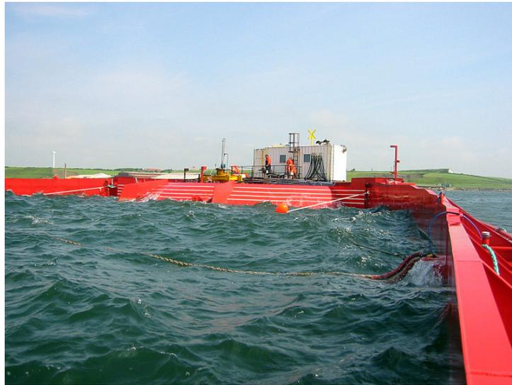
Fig. 3.11. El dispositivo Wavedragon captura las olas mediante un colector. [Wave Energy-
